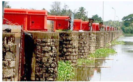
a. Thottappally spillway
